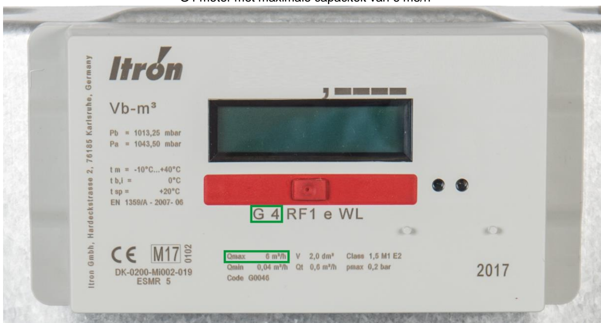
G4 meter met maximale capaciteit van 6 m 3 /h
